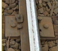
Mild Spalling
